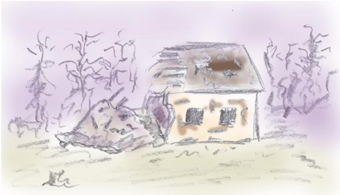
Das Dach war noch zur Hälfte vorhanden
